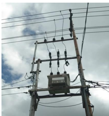
Gambar 3. Trafo Distribusi 50kVA
