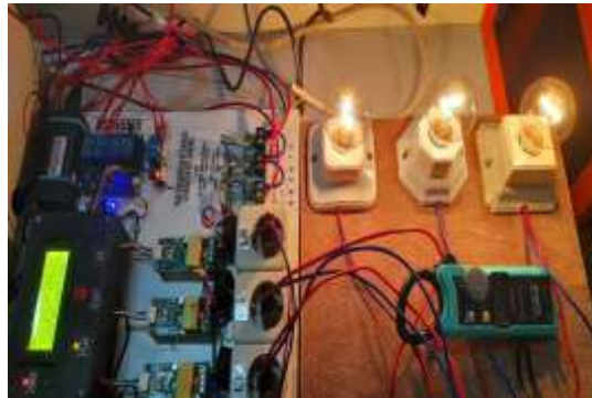
Gambar 20. Pengukuran Arus Sumber PLN dan Genset
